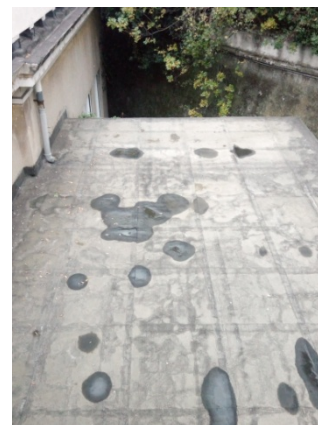
Figura 8.4 - Particolare copertura su cui intervenire.
