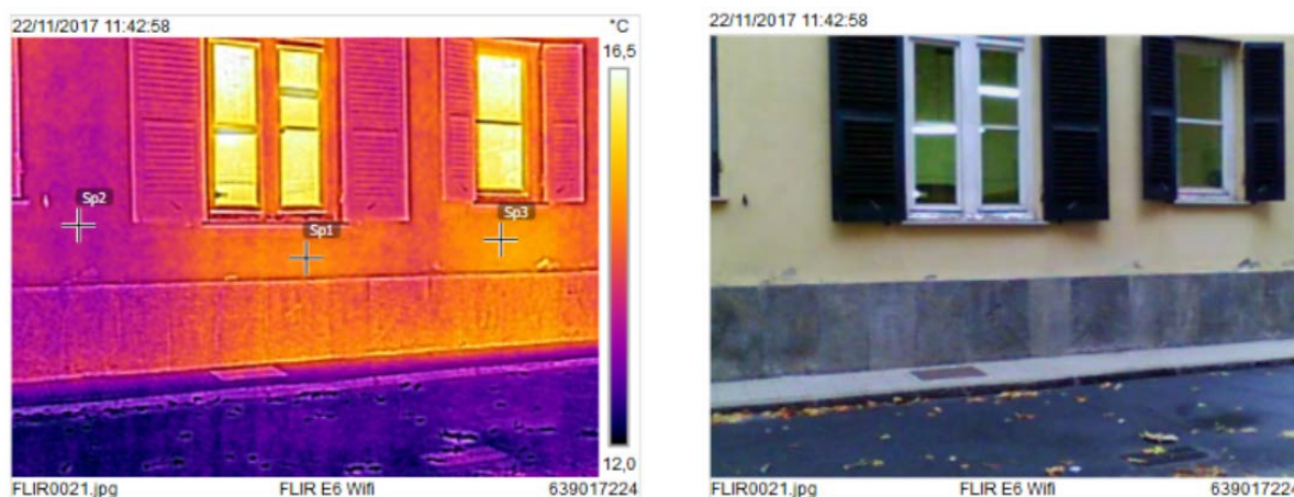
Figura 4.3 –Rilevamento termografico della parete ovest (immagine termografica – immagine visibile)
