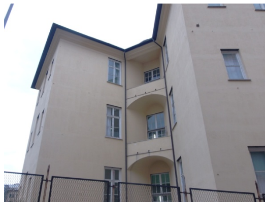
Figura 1.1 - Vista di una porzione della facciata Nord-Ovest
