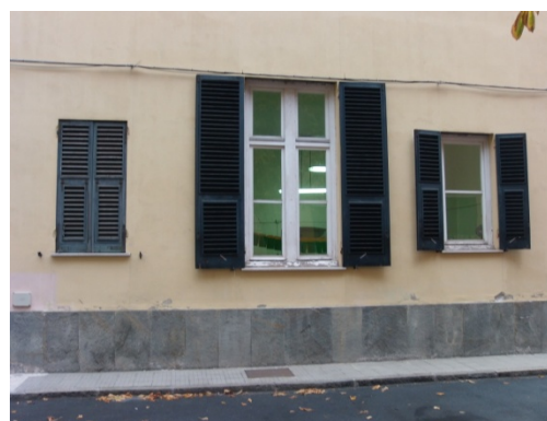
Figura 4.4 - Particolare dei serramenti - Legno vetro semplice
