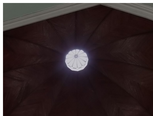
Figura 8.6 - Particolare copertura su cui intervenire – vista dall'interno
